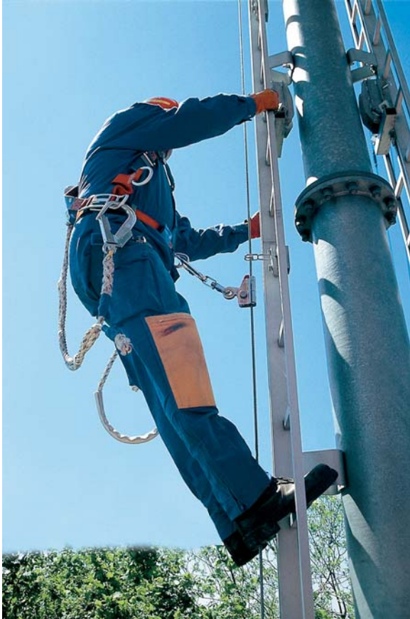
Bild 16: Beispiel einer Steigschutzeinrichtung mit Führung aus Stahldrahtseil
