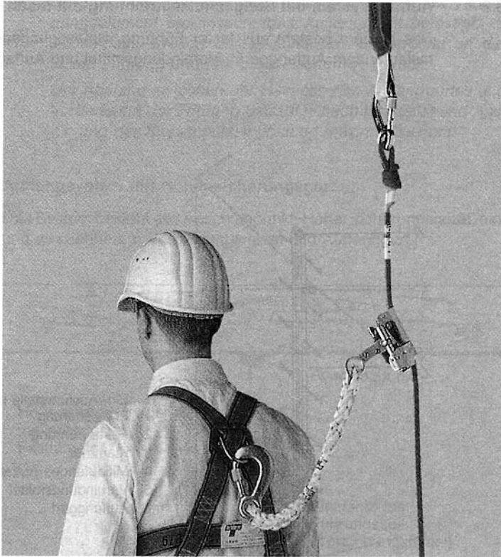
Bild 2: Beispiel des Auffangsystems: Mitlaufendes Auffanggerät einschließlich beweglicher Führung; hier befindet sich der Falldämpfer zwischen der beweglichen Führung und dem Anschlagpunkt
