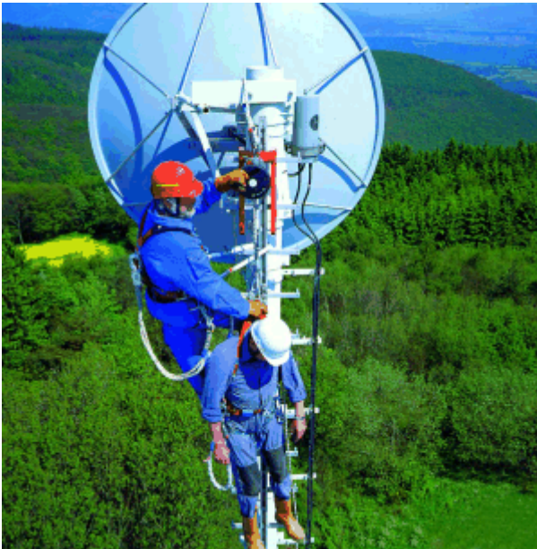
Bild 8: Abseilgerät mit integrierter Hubeinrichtung
