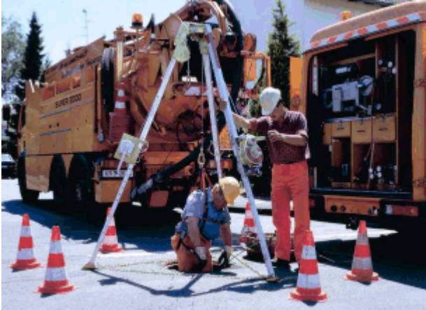
Bild 17: Rettung aus einem Schacht mittels Hörsicherungsgerät mit integrierter Rettungshubeinrichtung und transportabler Anschlagseinrichtung (Dreibein)
