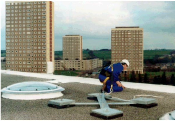
Bild 16: Durch Eigengewicht gehaltene Anschlageinrichtung (z.B. Betongewichte)
